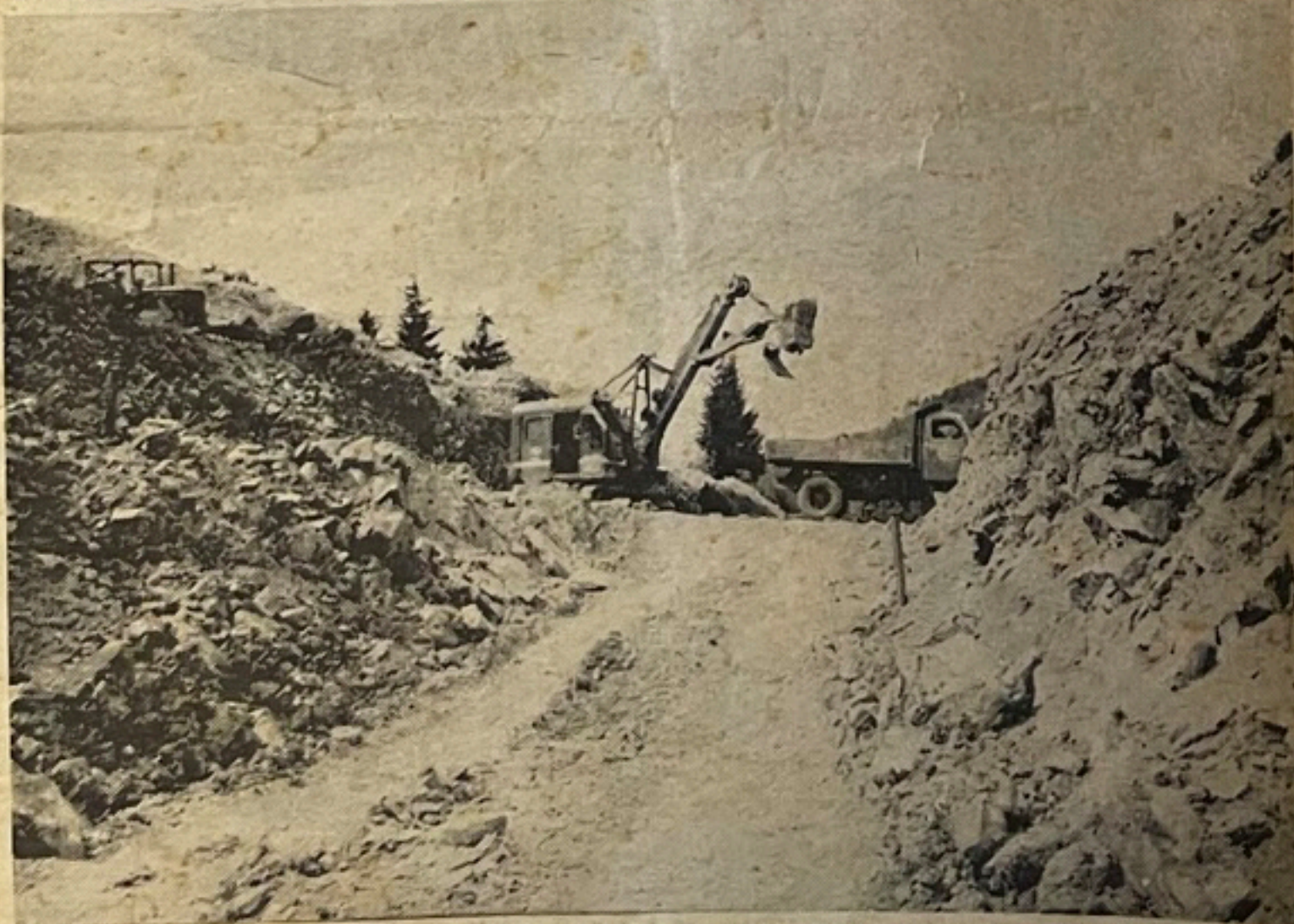
Münster. Das Baumaterial zur Errichtung des Dammes wird von einem benachbarten Berg abgetragen. Unsere Aufnahme zeigt einen Bagger bei der Arbeit.
